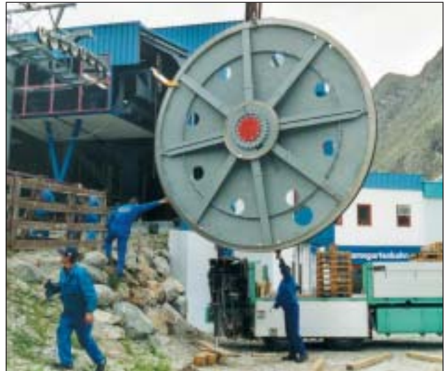
Links Leo Pfurtscheller und zwei Arbeiter der Fa. Doppelmayr
