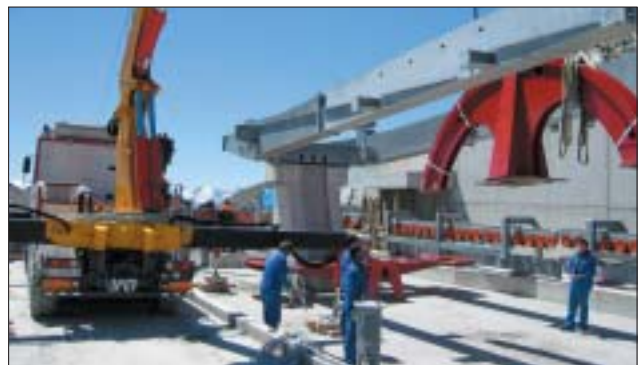
Montage der Stationseinrichtung
