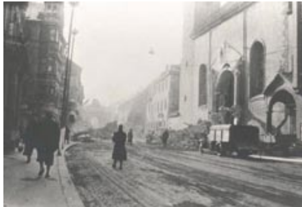
Links vorne die zerstörte Fassade des Gasthofs „Alte Post“. Rechts das schwer beschädigte Servitenkloster, im Hintergrund die Triumphalporte – heute steht anstelle der Ruine der „Alten Post“ silberglänzend unser neues Haus. (vgl. Seite 1)
